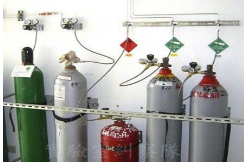
▲用這樣的欄杆也算是穩固，但是下方較短的鋼瓶則要注意單獨固定。
