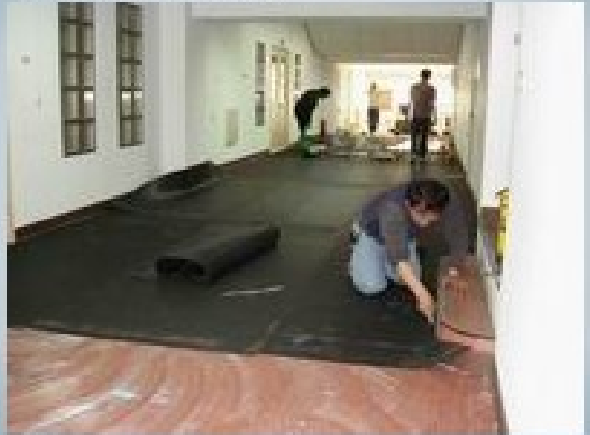
地板吸音工程
